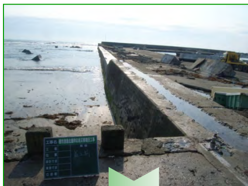
種市漁港：護岸復旧
