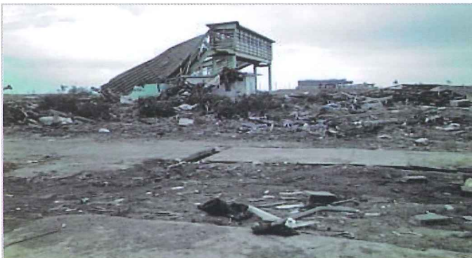
①倒壊した新地駅
