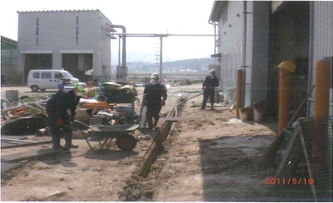
ボランティアによる瓦礫撤去作業ようす(新地町)
