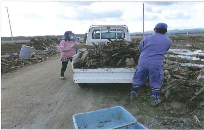
復興組合による瓦礫撤去作業ようす(相馬市)
