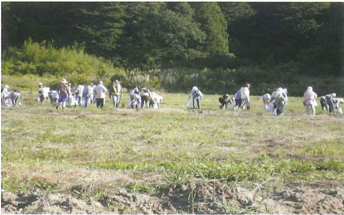
復興組合による瓦礫撤去作業ようす(小高区)
